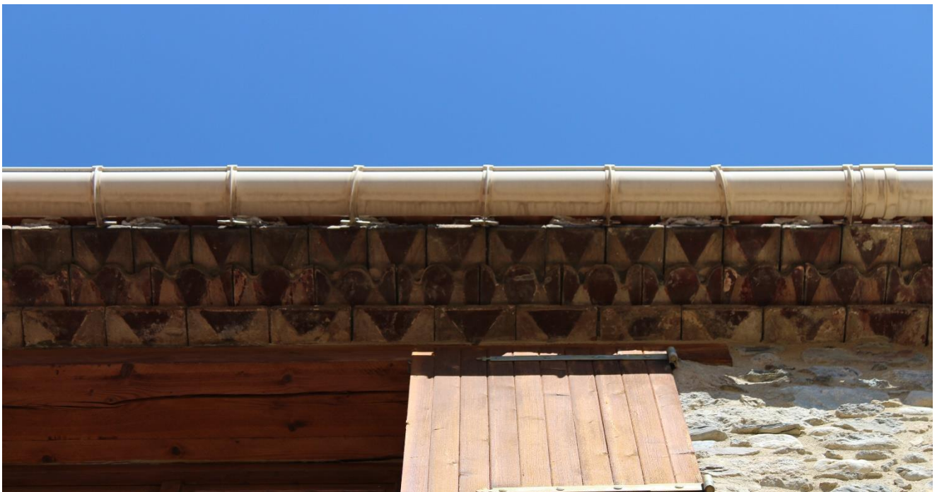
Tuiles posées directement sur le mur. La tour de Guidou Barral.
