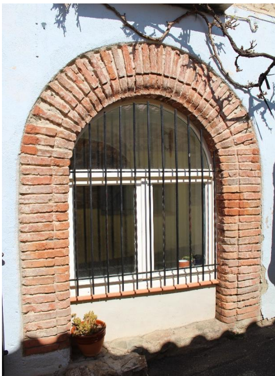
Belle façade décorée de « Cairons » (Rue de la Pastora).
