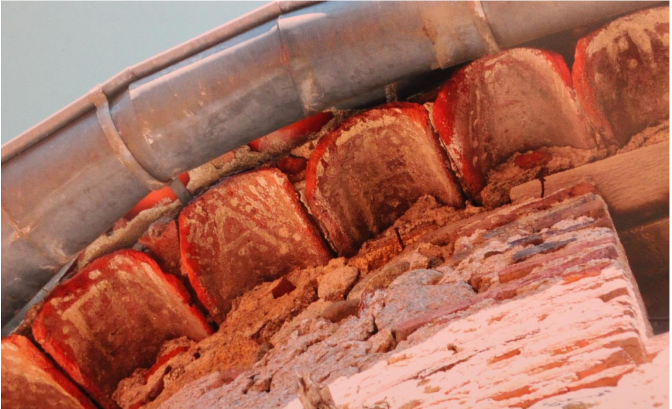
Tuiles posées directement sur le mur. La tour de Guidou Barral.
